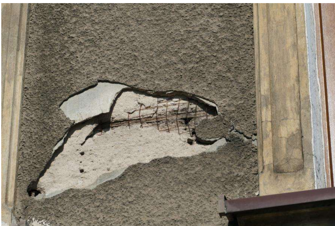
16. TYNKI - ZNISZCZENIA
