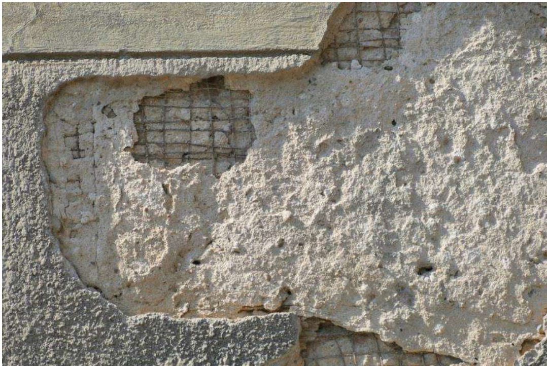
17-18. TYNKI - ZNISZCZENIA
