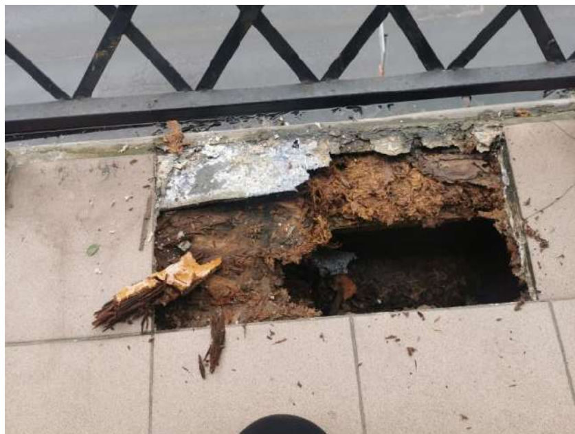
11-12. BALKON – ZBUTWIAŁA KONSTRUKCJA DREWNIANA
