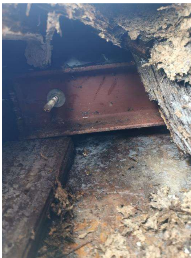
11-12. BALKON – ZBUTWIAŁA KONSTRUKCJA DREWNIANA
